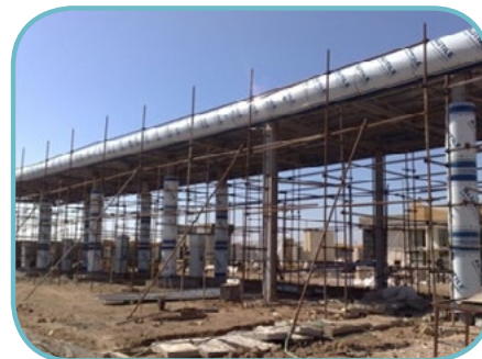
اجرای جایگاه سریع النصب
