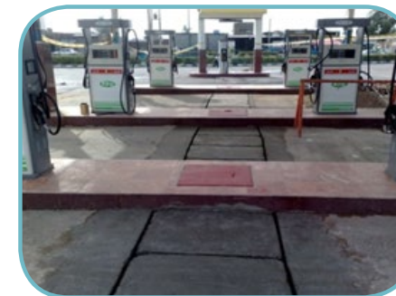
ایجاد سکوها و نصب دیستینگر و کانال تاسیسات
